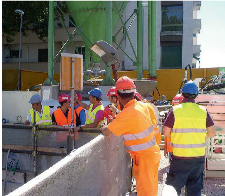
Quale futuro per l'edilizia? Sopra un cantiere. In alto Emanuele Bertini presidente di Cna Costruzioni
